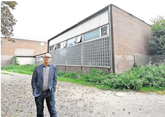
Ratsgymnasium: Schulleiter Manfred Filsinger hofft auf den baldigen Bau einer neuen Turnhalle.
