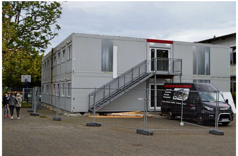
Noch nicht unterrichtsbereit sind die Container mit acht „mobilen Klassenzimmern“ auf dem Schulhof des Vechelder Gymnasiums.
