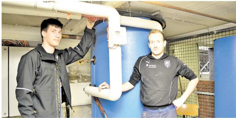
Auf der Suche nach den stillgelegten Leitungen im Peiner Ratsgymnasium: Mitarbeiter der Firma Gebrüder Deneke. pif
