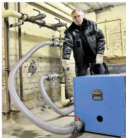
Trinkwasser-Desinfektion: Werner Ostermann mit der Desinfektionsanlage (im blauen Kasten) im Keller des Ratsgymnasiums.
