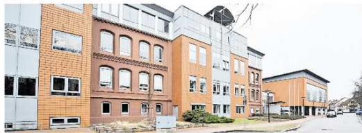
Peiner Ratsgymnasium: Am Montag wurden Proben entnommen, die eine hohe Keimbelastung aufwiesen.
